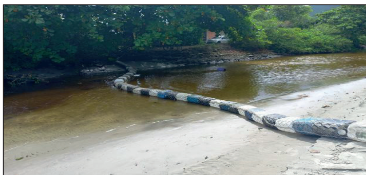
Figura 1 - Ecobarreira feita com galões
